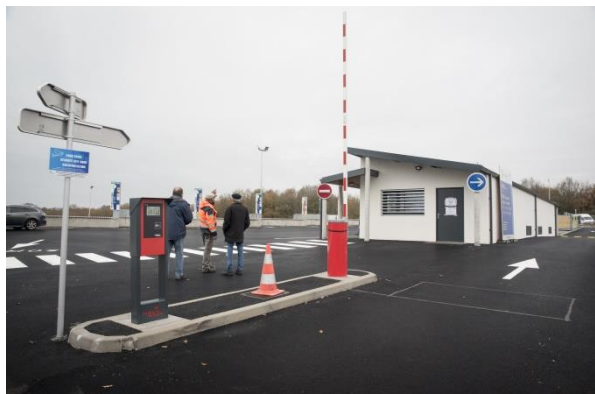
entrée avec contrôle d'accès
