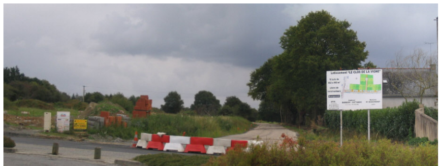
Lotissement du clos de la Vigne en cours
