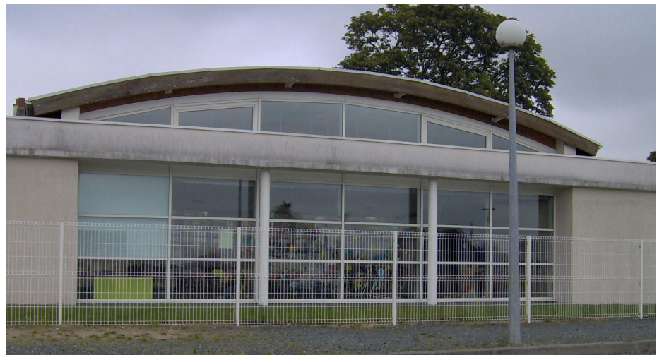
Le restaurant scolaire
