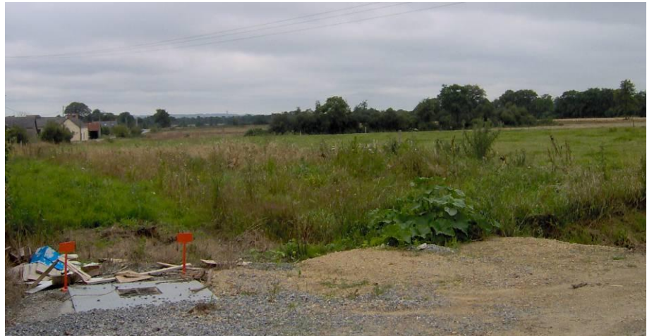
Extension en cours au Clos de la Vigne
